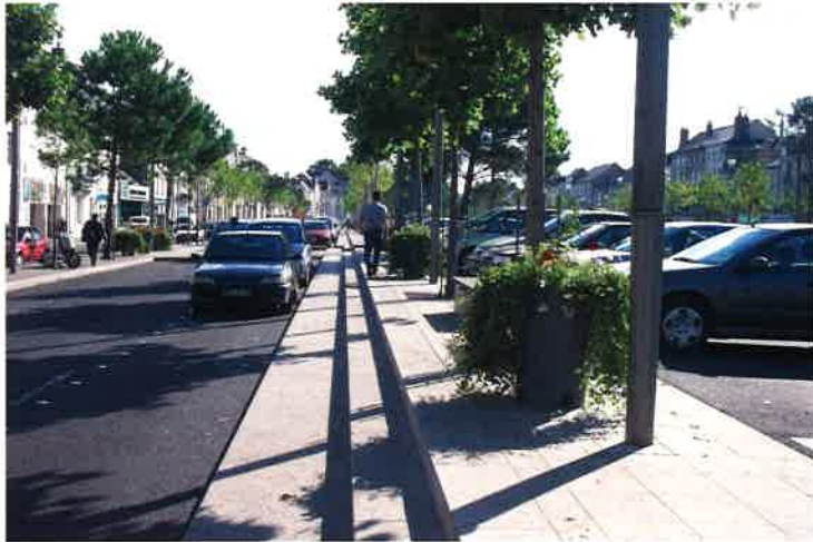
Le boulevard Blossac à Châtelleraut
